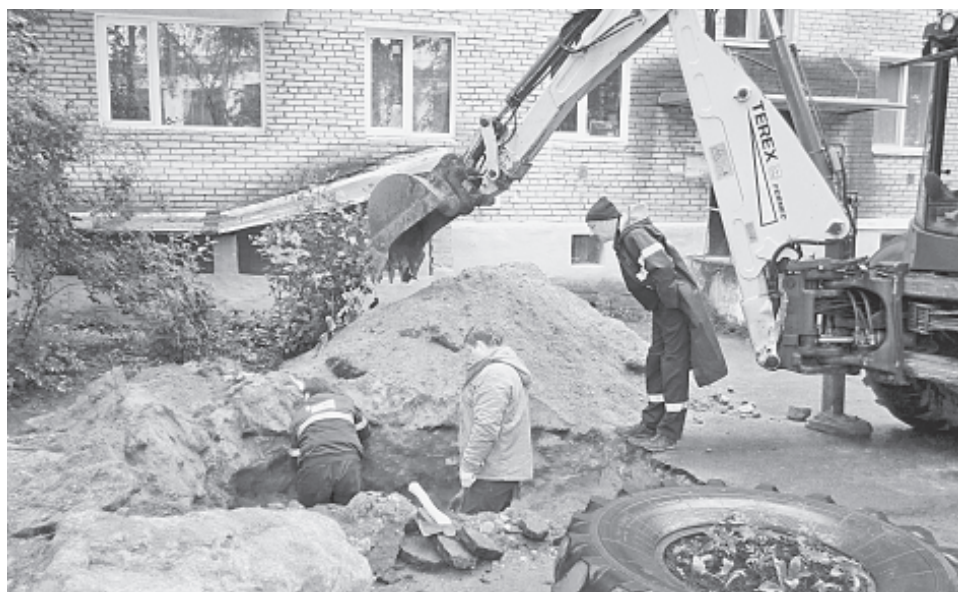
Земляные работы должны идти под контролем!
